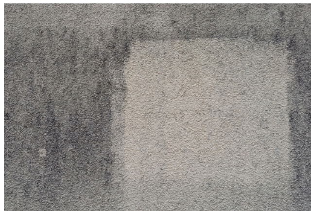
▲ Test FN® na velmi kontaminované fasádě probíhá již od r. 2011. Výsledky není třeba komentovat.
