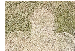
Fasáda napadená zelenou řasou po čištění
