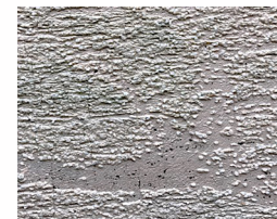
Degradace fasádní stěrky po 12 letech
