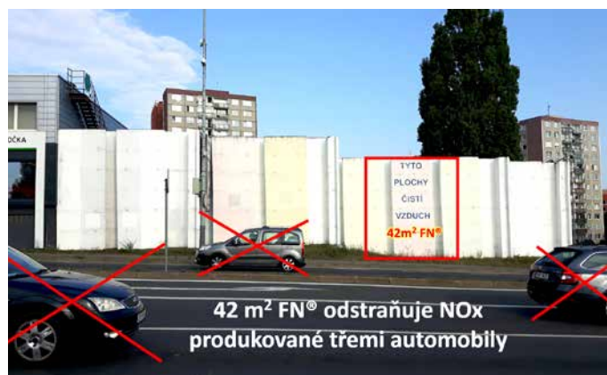
▲ Ukázka samočisticího efektu a rozdílu natřených a nenatřených ploch na protihlukové bariéře na Barrandově – stav po 5 letech
