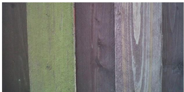
Dočasná sanace napadeného dřeva: Pokud nechcete černý povrch čistit, je možno použít k zakonzervování a postupnému vylepšení stavu jak FN® WOOD, tak levnější FN®1 (obr. vlevo).
