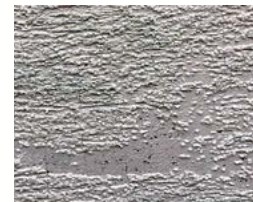
Degradace fasádní stěrky po 12 letech
