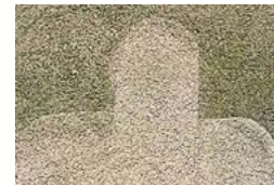
Fasáda napadená zelenou řasou po čištění
