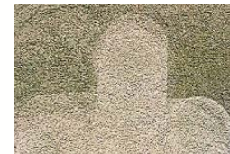
Fasáda napadená zelenou řasou po čištění
