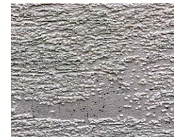
Degradace fasádní stěrky po 12 letech
